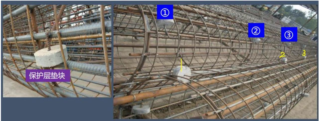
[P190 页三. 2. ] (4) 为保证保护层厚度, 钢筋笼上应设有保护层垫块, 设置数量每节钢筋笼不应小于 2 组, 长度大于 12m 的中间加设 1 组, 每组块数不得小于 3 块且均匀分布在同一截面的主筋上在回填土施工前, 项目部安排人员编制了回填土专项方案, 包括:按设计和规范规定, 严格控制回填土方的粒径和含水率, 要求在土方回填前做好清除基底垃圾等杂物, 按填方高度的 5%预留沉降量等内容
