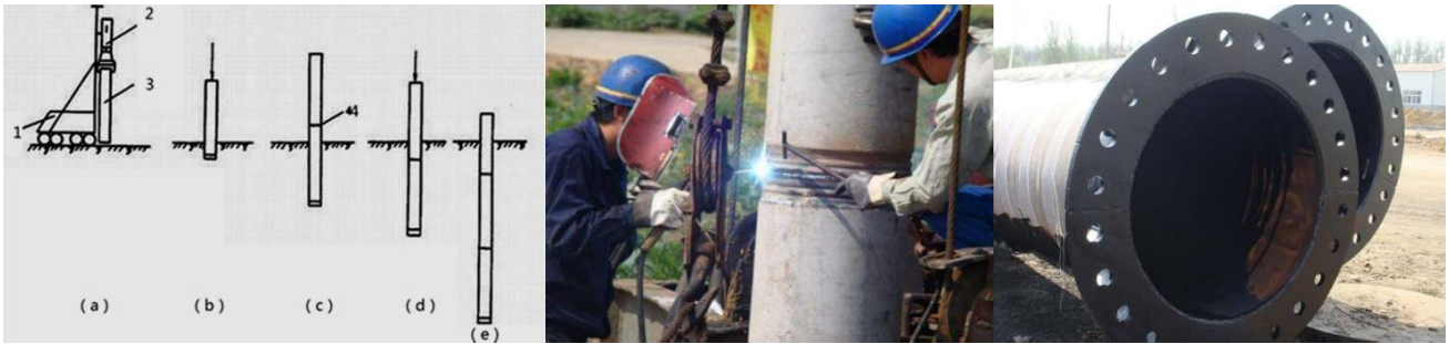
图 预制桩接桩
