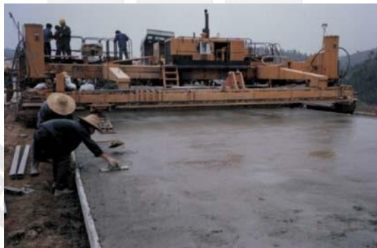
图 水泥混凝土路面滑模施工
