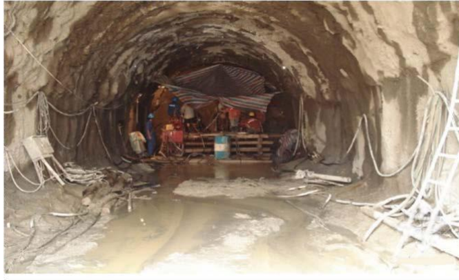
图 全断面法开挖
