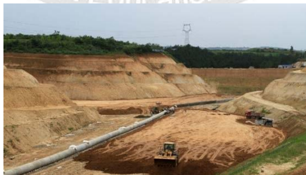
图 泥质防水层施工
