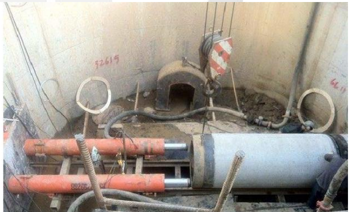
图 顶管施工
